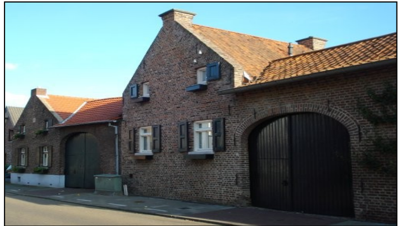
Foto 13: Gevelpartij a/d Haverterstraat (t.o. Oude Staat).
