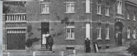
Woonhuis hoek Susterderpoort-Markt. Voorgrond (L) reling langs Geleenbeek.
