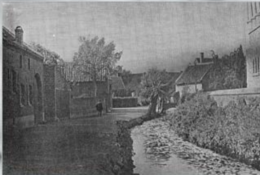
Beekstraat met Geleenbeek (stroomafwaarts). Rechts deel van de kerk(toren) zichtbaar.
