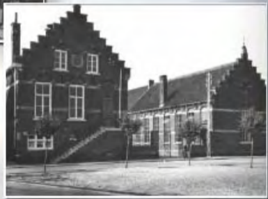
Stadhuis en jongensschool (gebouwd in 1884). Tweelingpanden met trapgevels. Situatie rond 1938.
