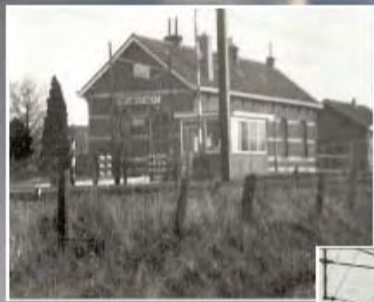
Stationsgebouw gelegen aan de spoorlijn Maastricht-Venlo (km. 26).
