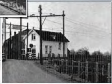
Spoorwegovergang van de Elsenewal naar Aan de Bogen. Dienstwoning op achtergrond.
