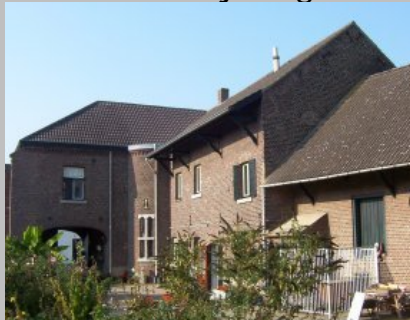
Kijkje op kwartronde toren tussen poort en de achterbouw. Helemaal rechts (achter de achterbouw) is de moutkamer.
