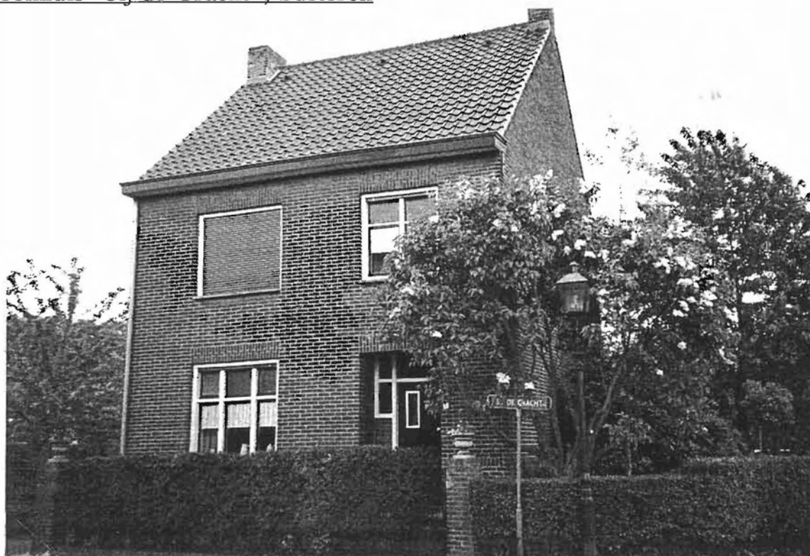
Woonhuis "bij de Gracht", Susteren
